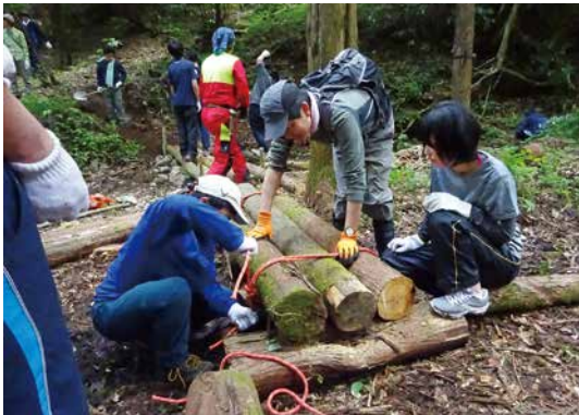
足場の丸太をロープで固定
