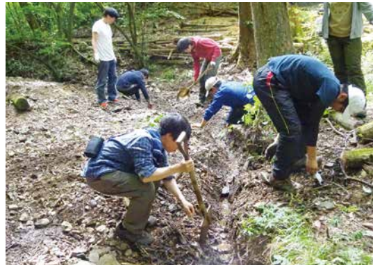
途切れた沢の流れを掘り起こして復旧
