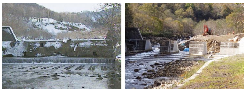
写真4 羅臼川砂防ダムの改良 (左: 実施前, 右: 実施後) ダムの一部を撤去し、スリットダム化している。
